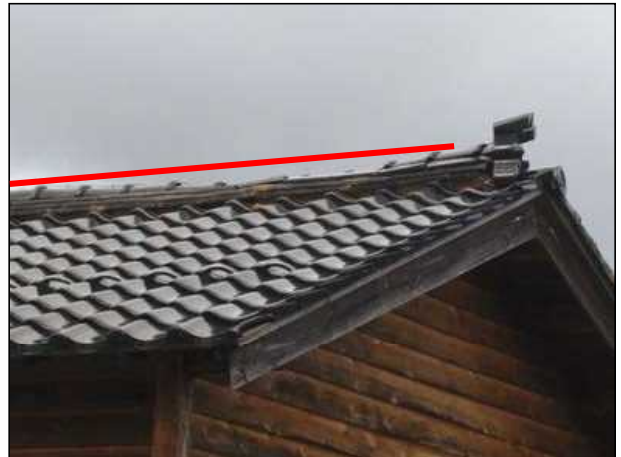
棟瓦のずれ、破損、落下が著しいが、その他の瓦の破損は少ない。
