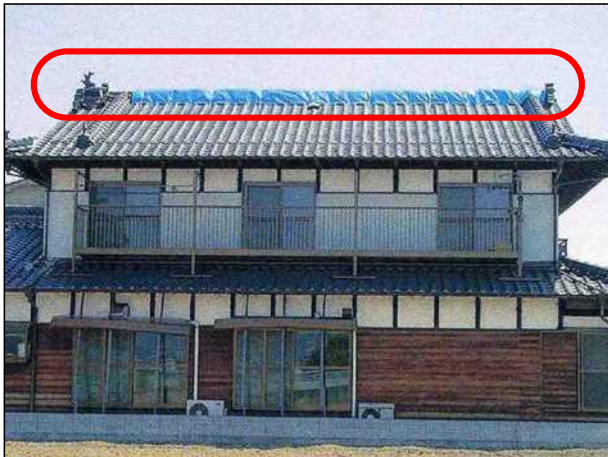
棟瓦のずれ、破損、落下が著しいが、その他の瓦の破損は少ない。
