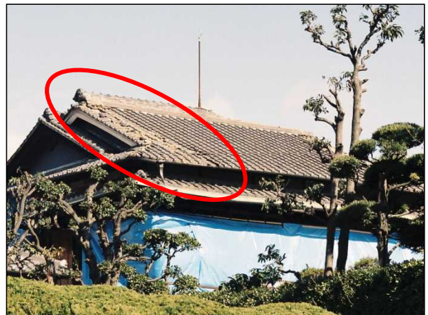
棟瓦以外の瓦もずれが著しい。
