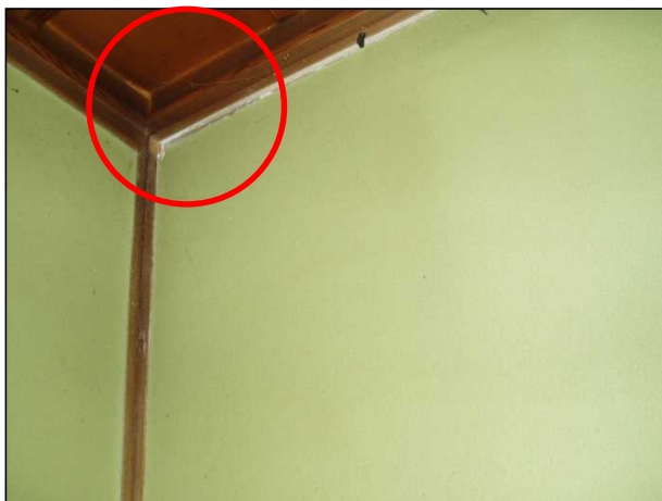
内壁周辺部に隙間が生じている。
