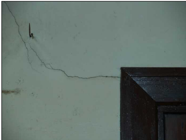
塗り壁隅角部にわずかなひび割れが生じている。
