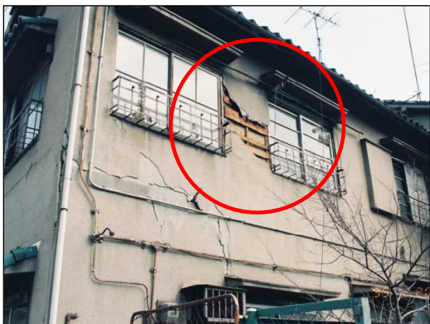
仕上材が脱落している。
