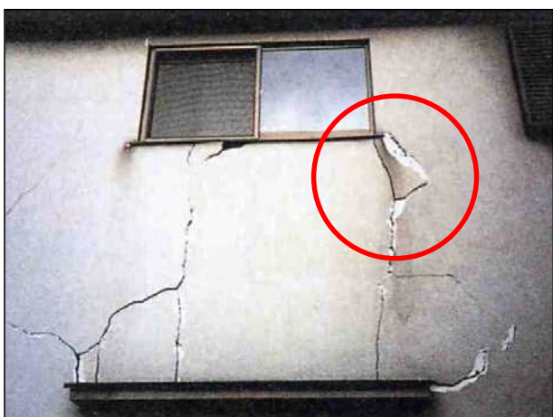
仕上の剥離が生じている。
